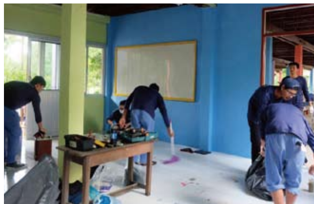
壁や床の修復作業
