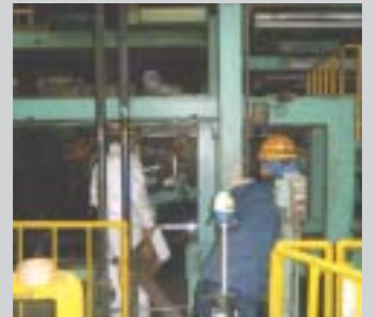
被災した納入設備の点検・調整
