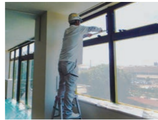
窓ガラスに遮熱塗料を塗布する様子
