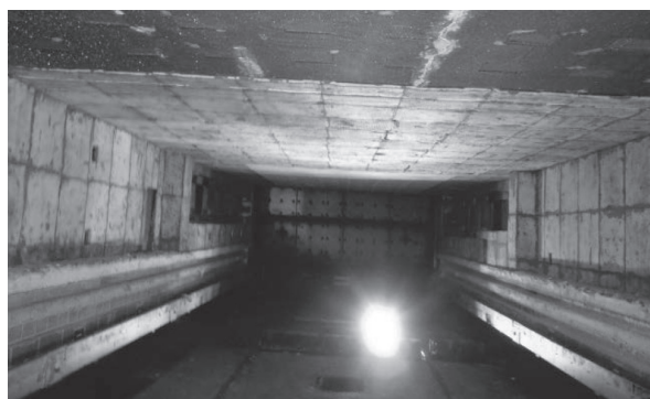
図2 接着技術を用いた炉壁への断熱施工
