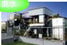
廃水処理装置
